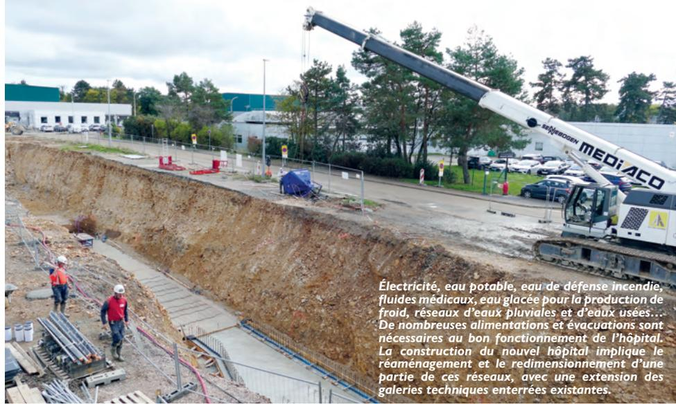
Électricité, eau potable, eau de défense incendie, fluides médicaux, eau glacée pour la production de froid, réseaux d'eaux pluviales et d'eaux usées... De nombreuses alimentations et évacuations sont nécessaires au bon fonctionnement de l'hôpital. La construction du nouvel hôpital implique le réaménagement et le redimensionnement d'une partie de ces réseaux, avec une extension des galeries techniques enterrées existantes.
