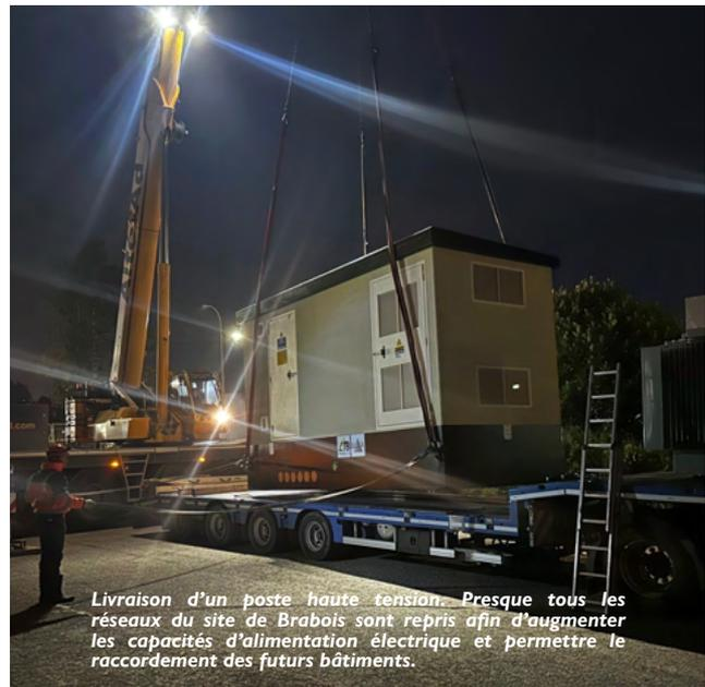
Livraison d'un poste haute tension. Presque tous les réseaux du site de Brabois sont repris afin d'augmenter les capacités d'alimentation électrique et permettre le raccordement des futurs bâtiments.
